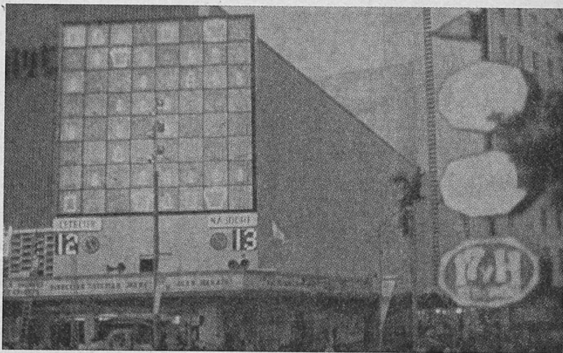
Elektroniskakbrættet på radiobygningens gavl
